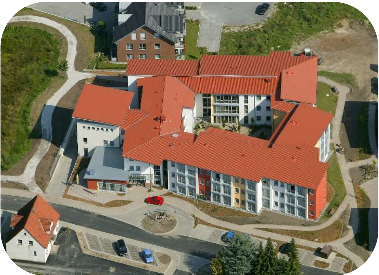
Luftaufnahme des Hauses nach der Fertigstellung im Jahr 2005
